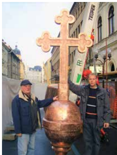
Foto: arhiv Rudi Rudnik - obnova zvonika in Marijine cerkve v Celju
